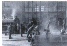
/ A Miskolci Egyetem építése, 1950-es évek /
